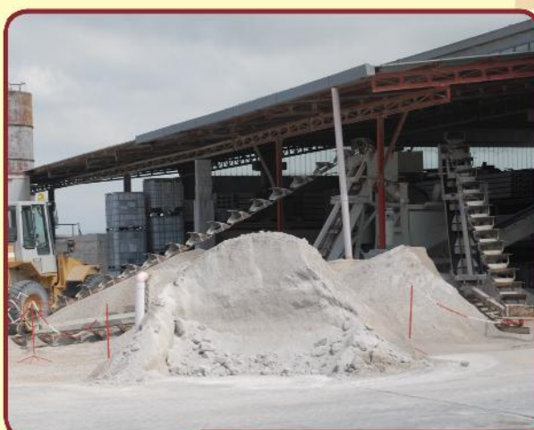
Fasi di lavorazione
